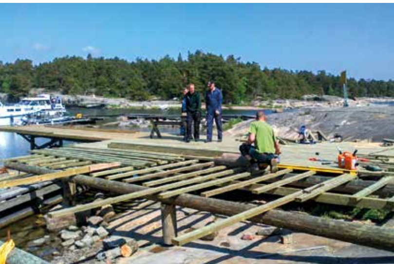
Uuden laiturin rakentaminen.
