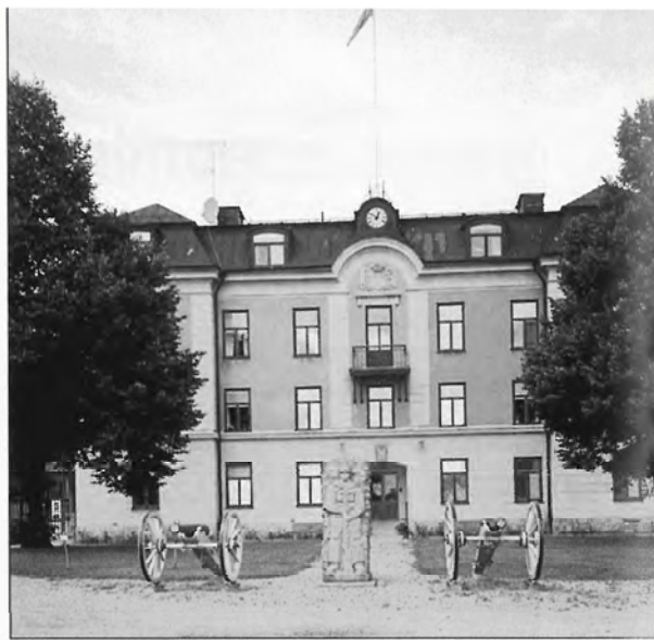
SK/KA 1:n esikuntarakennus ja viime sodan muistomerkki.
